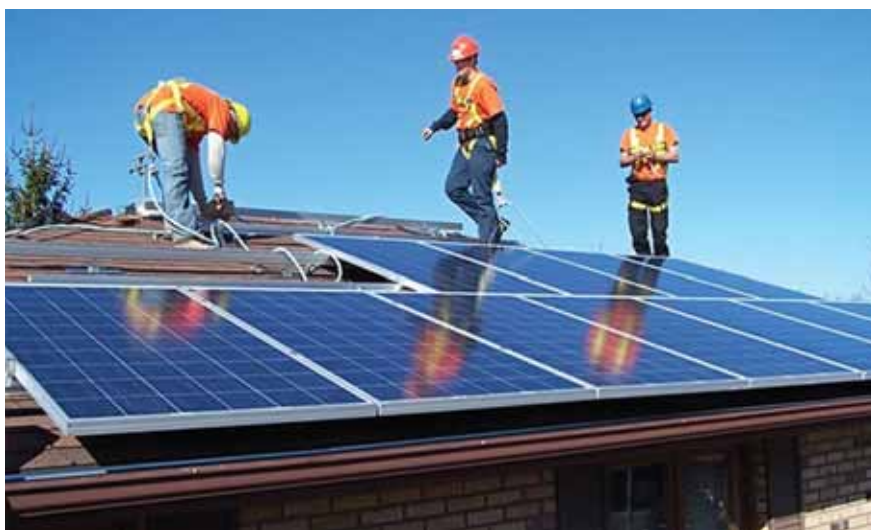
Монтаж солнечных батарей на крыше жилого дома.
