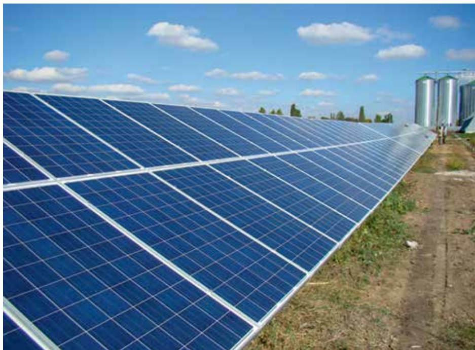
Современная солнечная электростанция.
