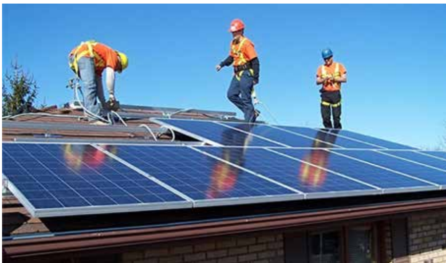
«Зеленая энергетика»: монтаж солнечных батарей на крыше жилого дома.
